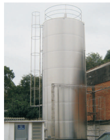
MELHORIA: acesso facilitado e mais seguro
